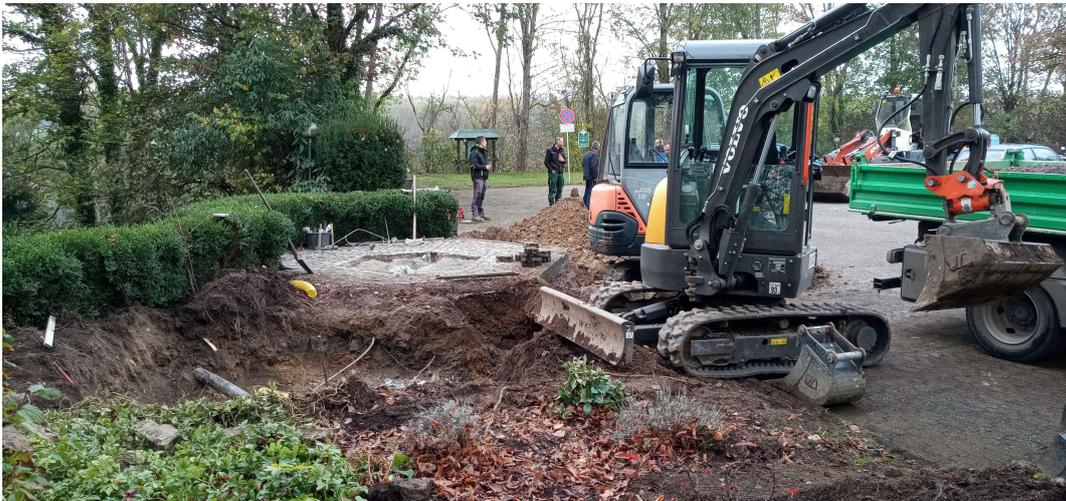
Nach dem Ausschachten wurde die Grube mit Schotter als Unterbau aufgefüllt.
