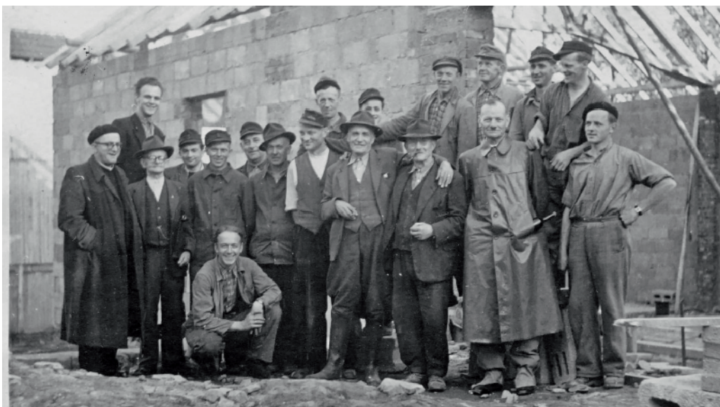
Foto: Bau des Dorfgemeinschaftshauses - Richtfest.
